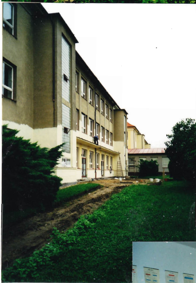
oprava fasády budovy 1. stupně a rekonstrukce chodníku.
